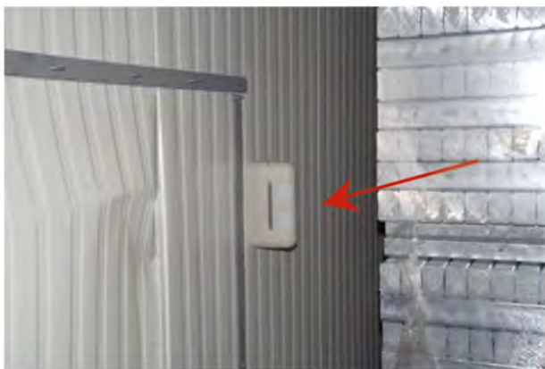
145-21 Streckenmelder 2 x 12 m im Innenbereich zur Überwachung der Hallenrückwand, Montagehöhe 0,8 m
