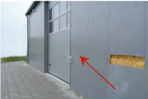
145-21 Streckenmelder 2 x 12 m im Außenbereich zur Überwachung von Tor und Außenwand, Montagehöhe 0,8 m
