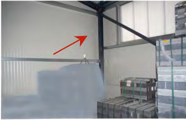
146-21 PIR-Flächenmelder in der Halle rechte hintere Ecke auf 3 m Höhe
