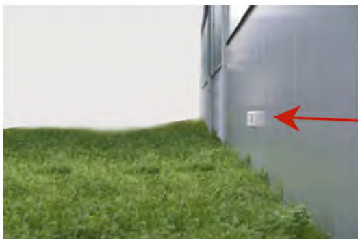
145-21 Streckenmelder 2 x 12 m im Außenbereich zur Überwachung von Tor und Außenwand, Montagehöhe 0,8 m
