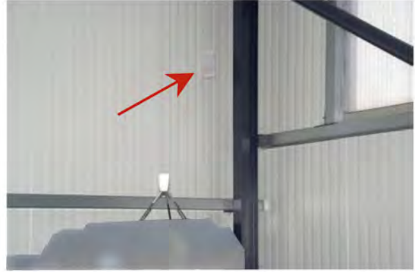
146-21 PIR-Flächenmelder in der Halle rechte hintere Ecke auf 3 m Höhe
